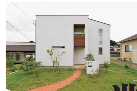
業務負担の低減と設計・施工品質の向上を両立した小沢工務店の住宅。
